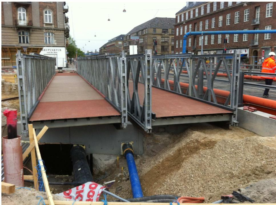
Parallel montierte C200-Fußgängerbrücken – Phase 1 – Länge 27,45 m, Breite 2 x 2,50 m
