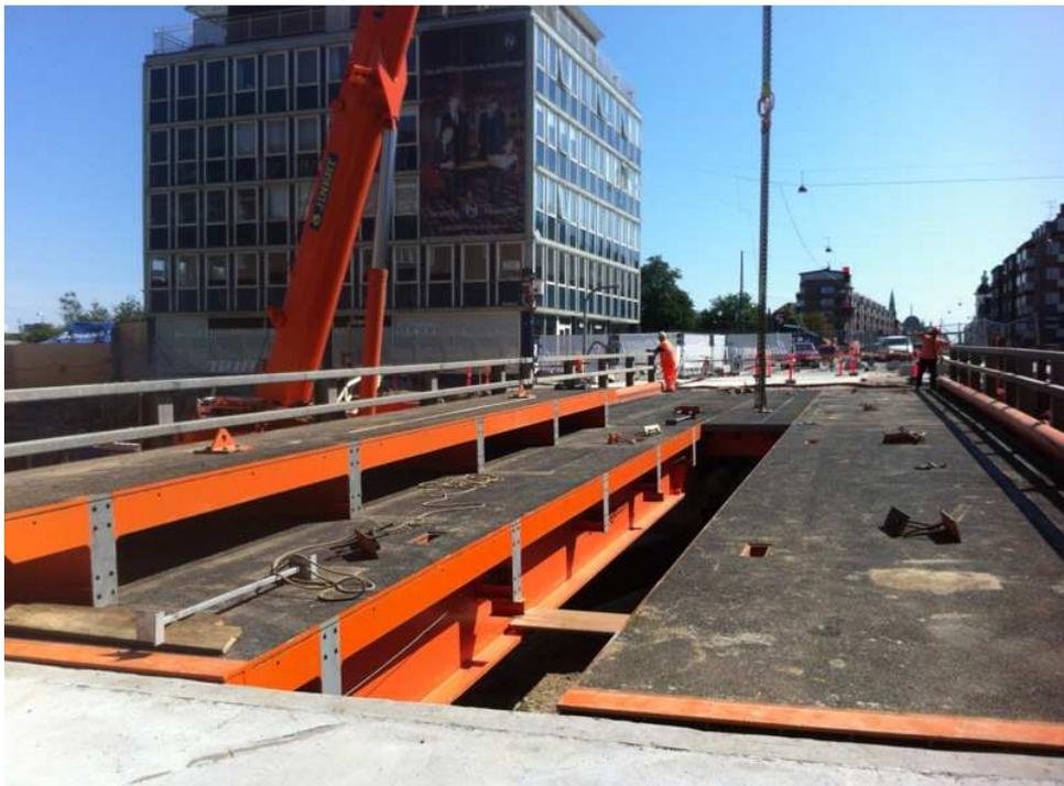
Montage eines RLB-Zwischenteiles in einer Verkehrsbrücke – 2 x 3,00 m
