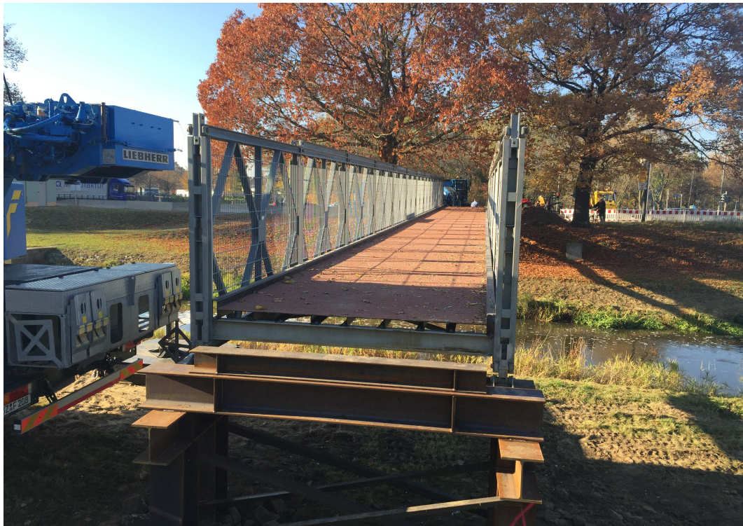
Behelfsbrücke, Fahrbahnbreite 2,50
