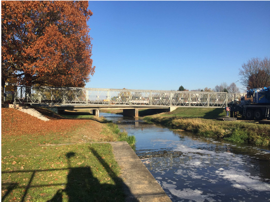
Fußgängerbrücke mit 33,53 m freier Spannweite
