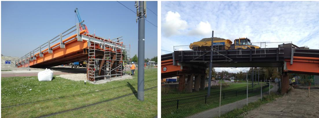
RHB-Brückenrampen und Mittelspannweite aus RBB-Brückenelementen
