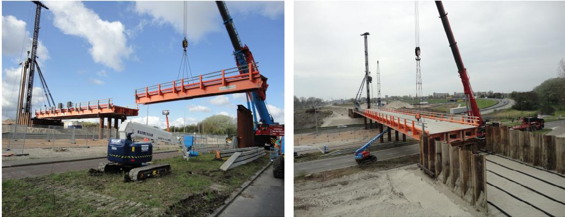
Einheben des Mittelfeldes (21,00 x 3,00 m) und Endmontage der Brücke
