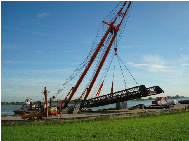
HG-Brücke am Vormontageplatz – Laden mit Schwimmkran
