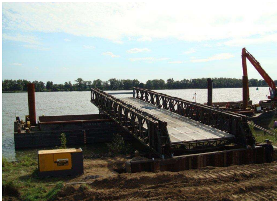
Widerlager der Brücke und Ponton
