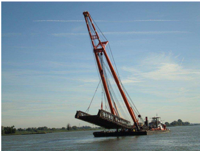
Verfahren der Brücke zum Einsatzort (ca. 4 km)
