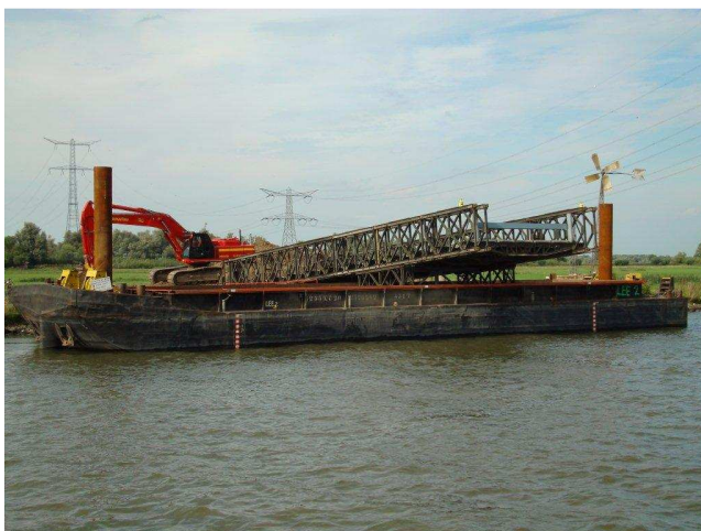
Fertiggestellte HG-Brücke mit Schwimmponton (Schute)
