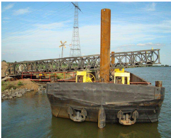
Schute mit Stützpfehlen und Behelfsbrücke
