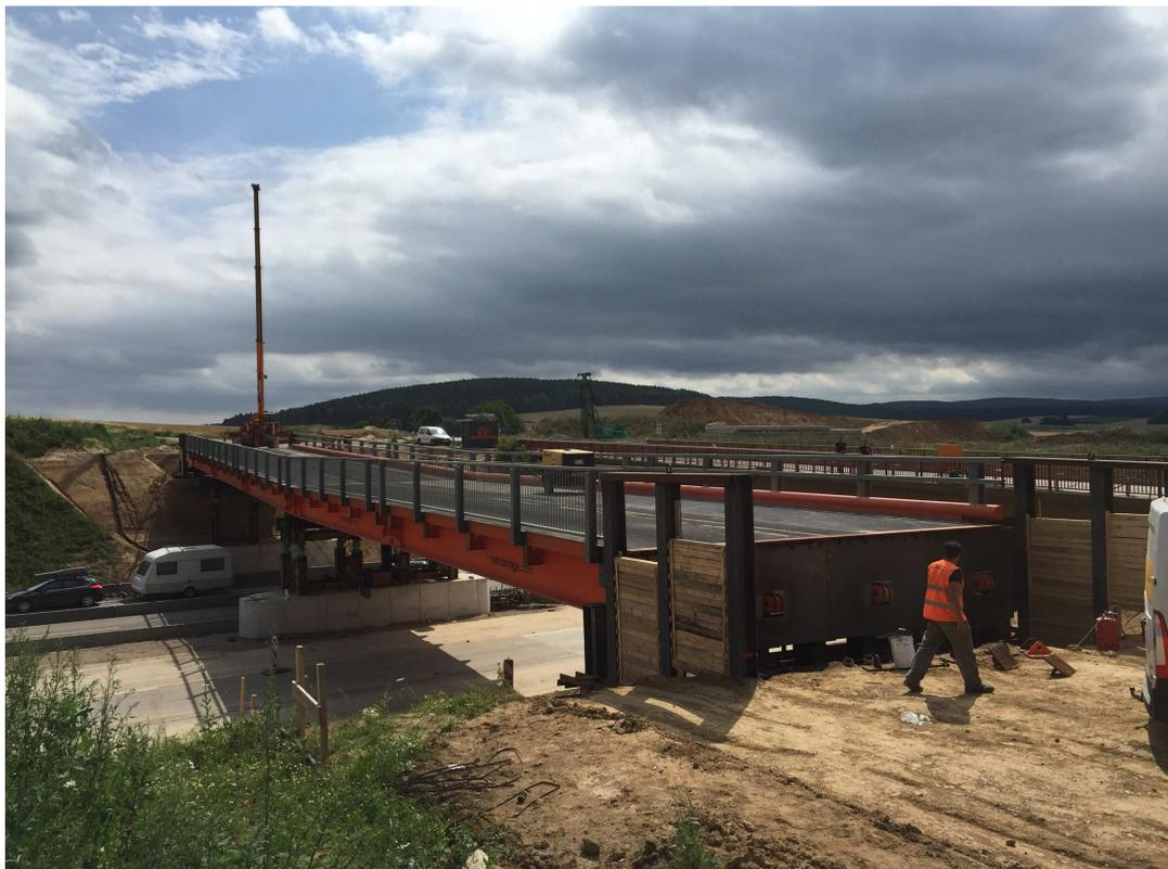
Fertiggestellte Behelfsbrücke im 3-Feldsystem – Gesamtlänge 68,58 m
