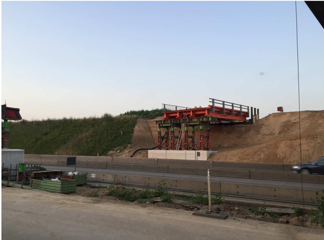
Behelfsbrücke Typ RLB außerhalb des Autobahnkörpers der A7
