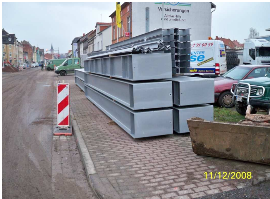
Lieferung von positioniertem Brückenmaterial
