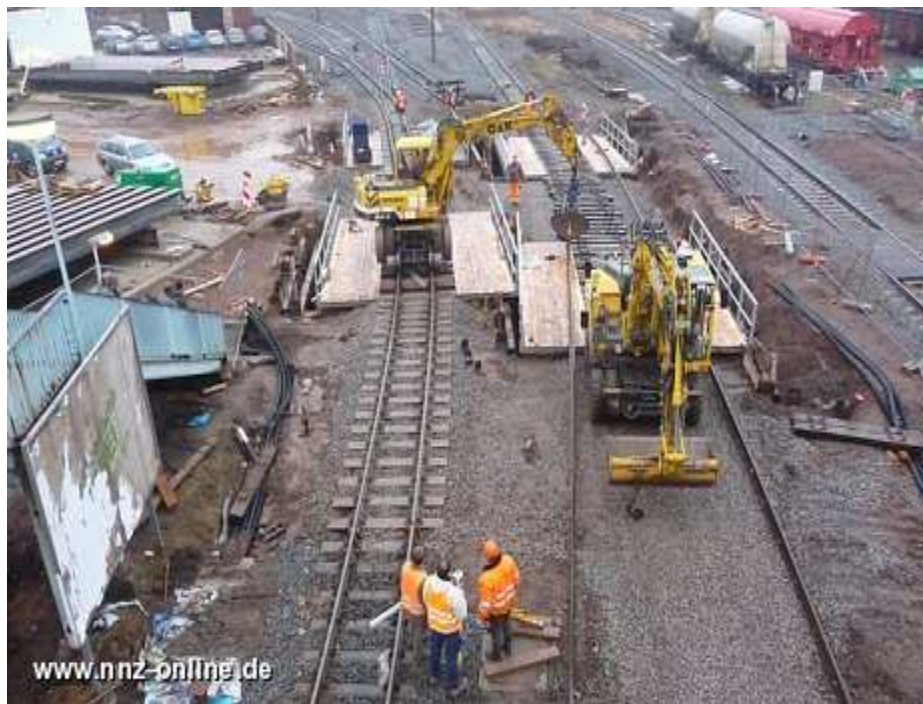
Fertiggestellte Brücken mit Anbindung an das Gleisbett
