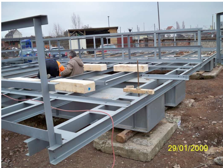
Vorgefertigter Stahlbau mit Verbänden u. Schutzgeländer
