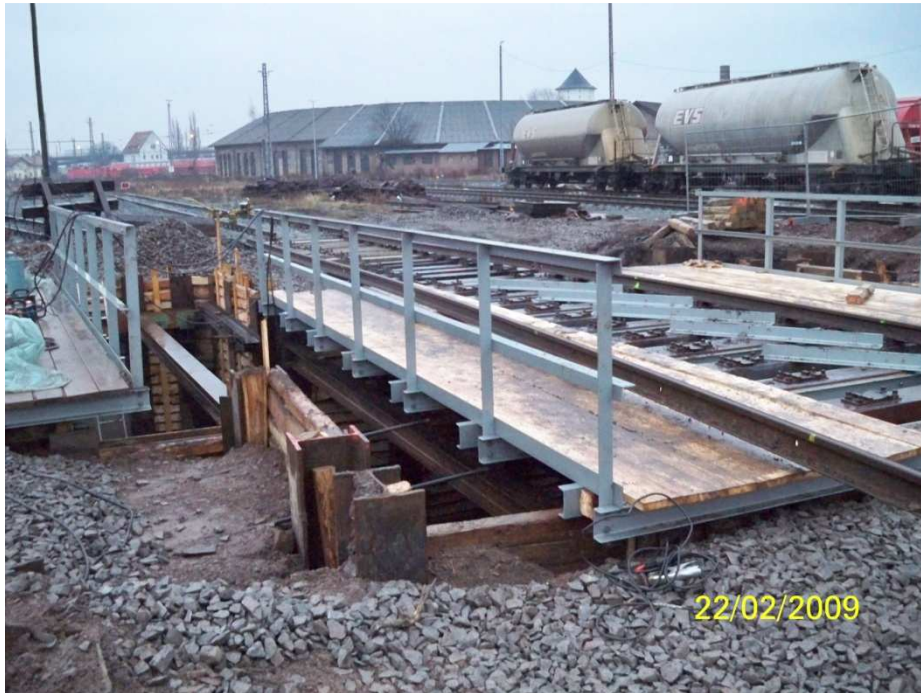
Behelfsbrücke mit Schienen, Gehweg und Holzbelag
