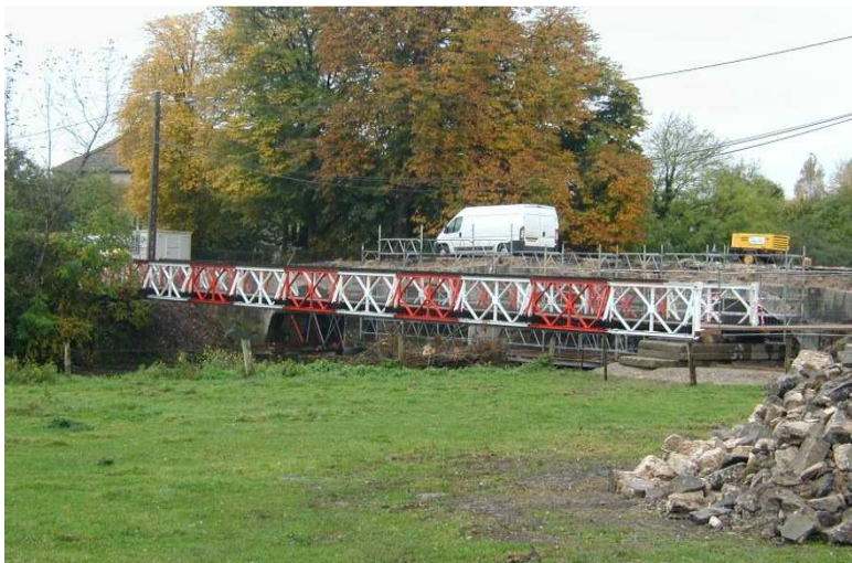
Fußgängerbrücke in der Stadt Neuville (Frankreich)
