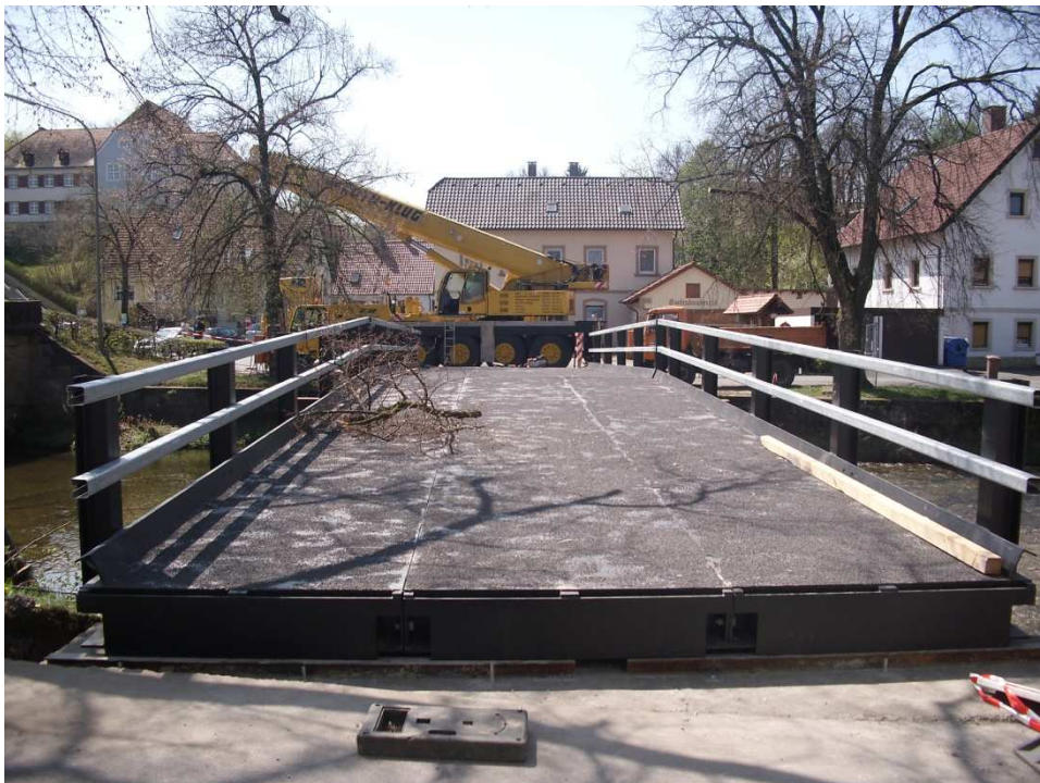
Widerlager mit Auflagerleiste und Verschraubung, Fahrbahnbreite 5,10 m
