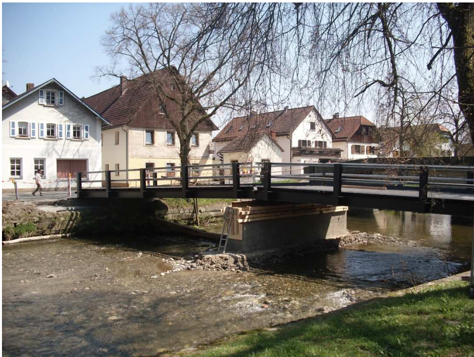
RBB-Brücke mit Mittelstütze über dem Main
