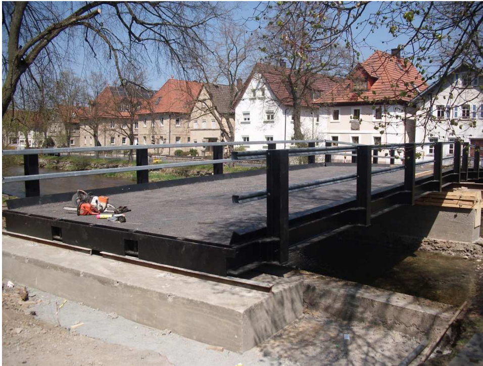
Behelfsbrücke mit Geländern und Radabweisern (Anprallschutz - Klasse A)
