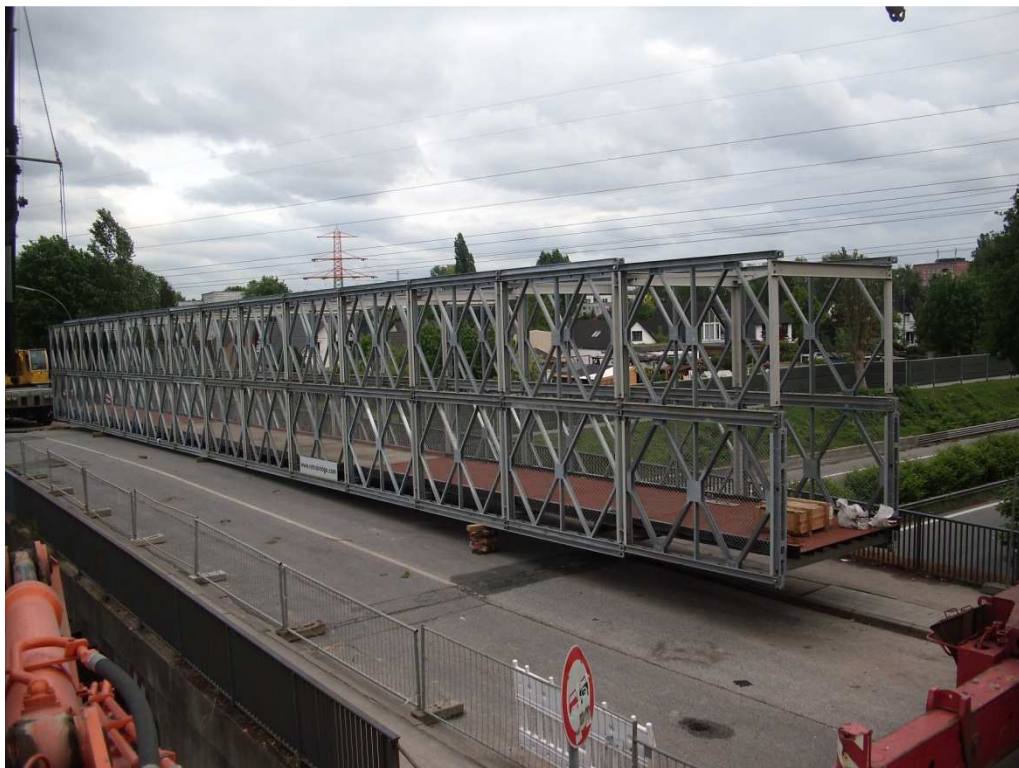
Komplettierte Brücke mit 42,70 m freier Spannweite fertig zum Einheben
