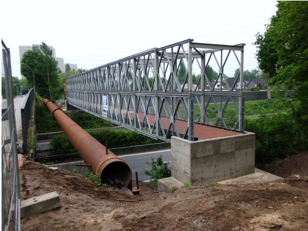
C200 - Behelfsbrücke über der BAB A24 in Hamburg mit Widerlagern
