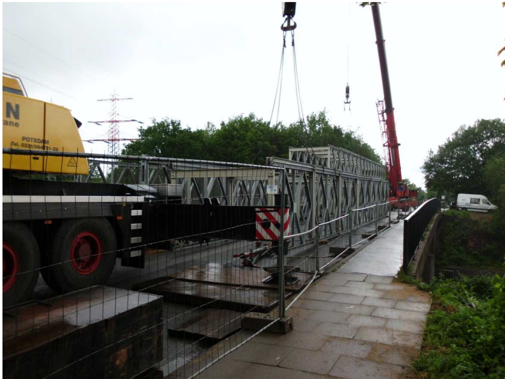
C200 Brücke – Anlieferung der vormontierten Brückenteile
