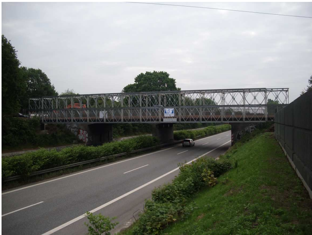
C200 - Behelfsbrücke ohne Mittelstütze, freie Spannweite 42,70 m
