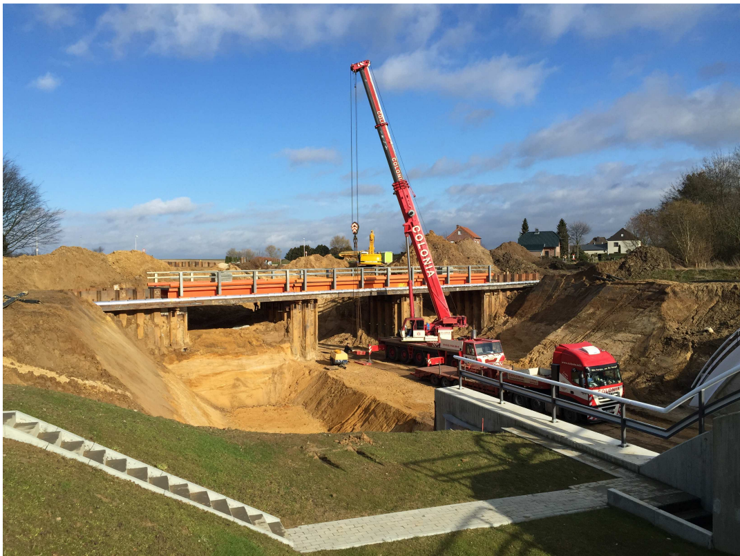
RHB- Brücke während der Montage von der B 56 n aus
