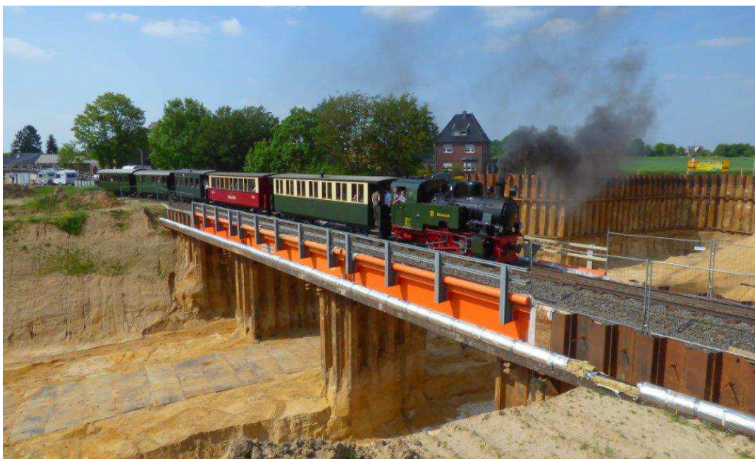
Behelfsbrücke mit der Selfkantbahn (Schmalspurbahn)
