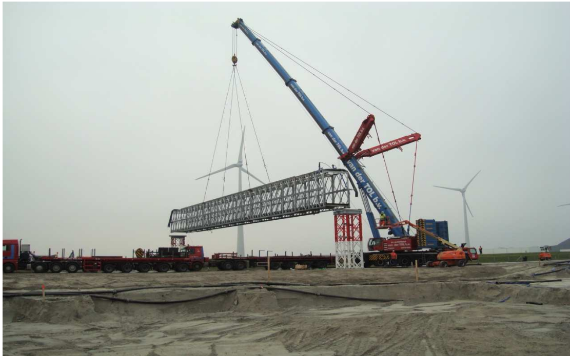
Einheben der kompletten Brücke (inkl. Leitungen) auf Auflagertürme
