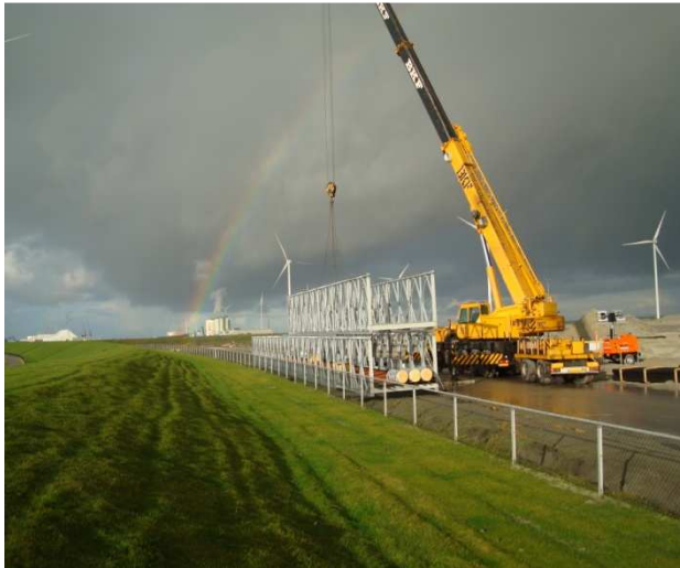
Vormontage der Brücke
