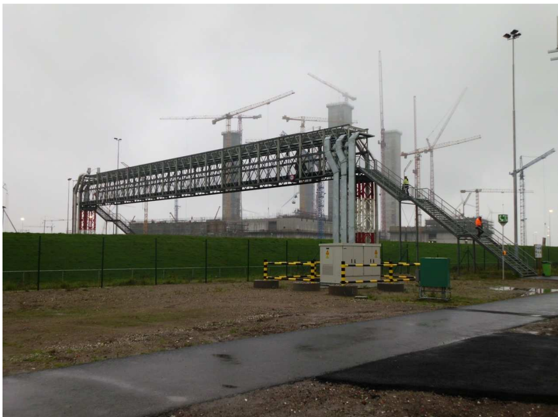
Brücke in Betrieb mit Treppentürmen und verlegten Leitungen
