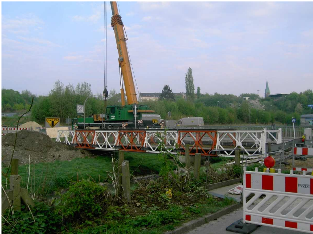
Fußgängerbrücke über die Emscher in Dortmund
