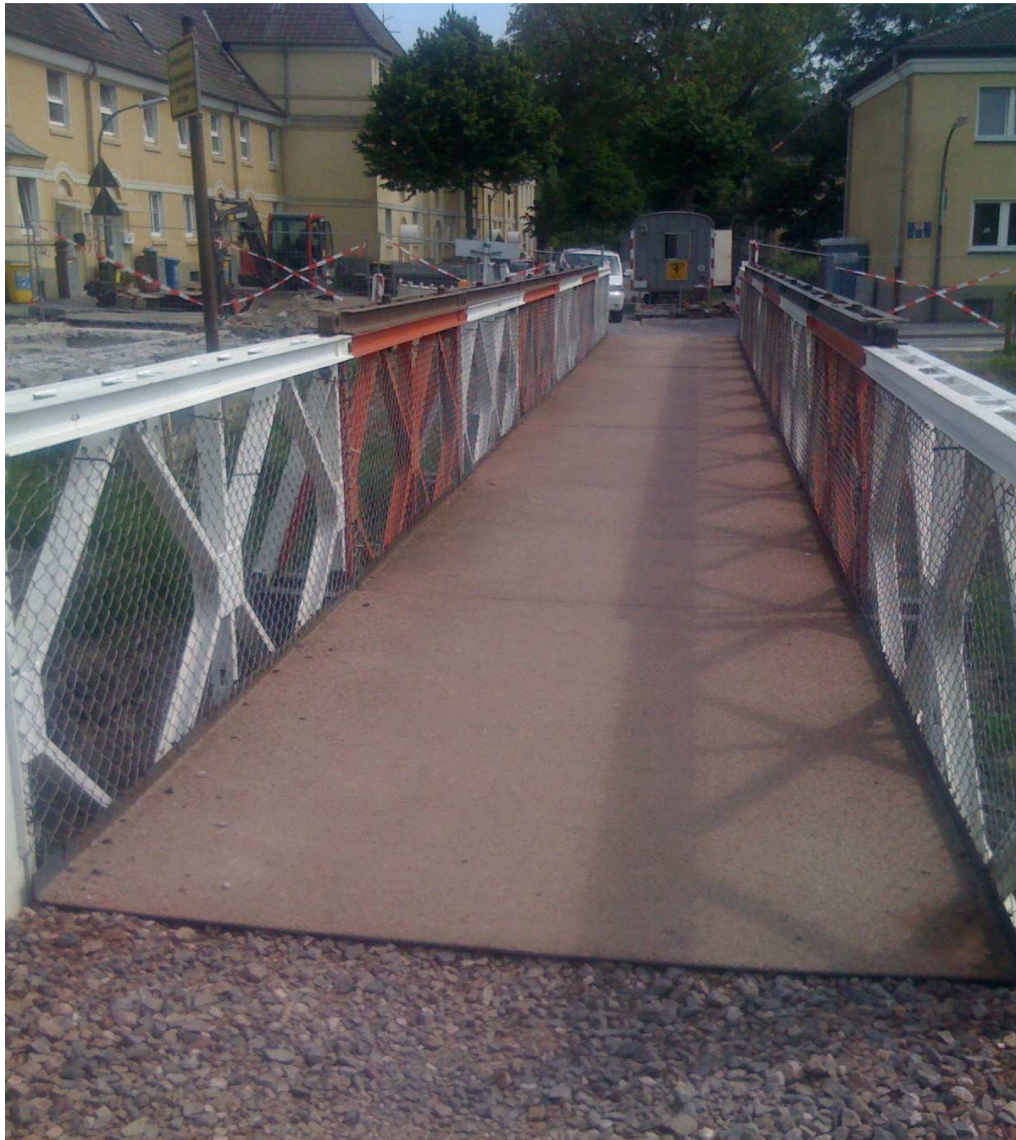
Brückendeck mit rotem Epoxidharzbelag und seitlich abgespannten Bailey-Fachwerkpanelen – Durchgangsbreite 2,00 m
