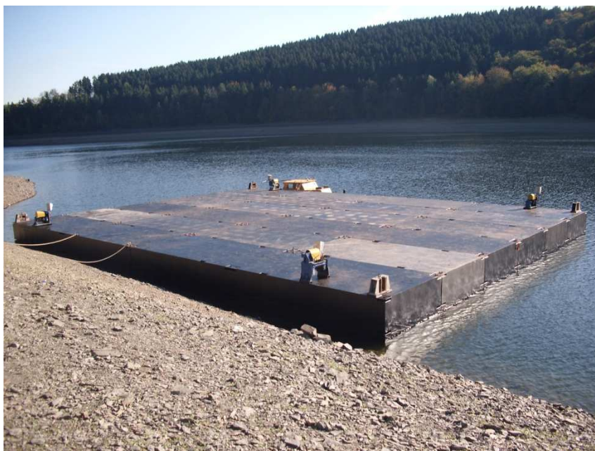
Ponton 24,00 x 18,00 m nach der Montage
