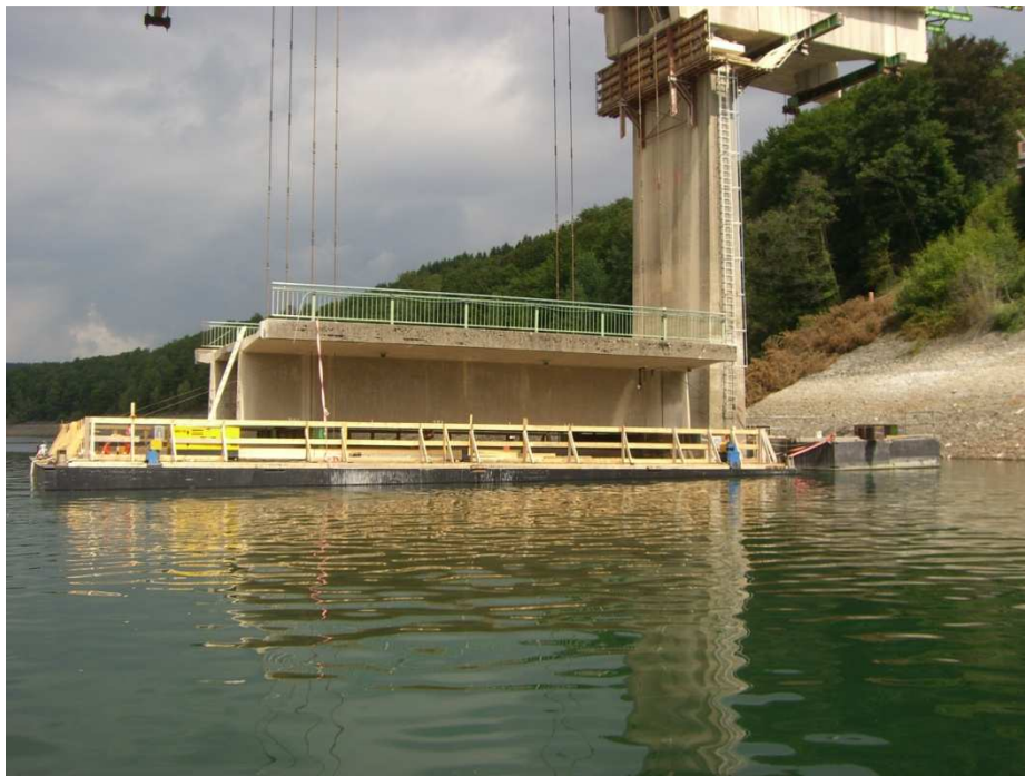
Ponton mit abgesenktem Brückenteil - Last ca. 385 t
