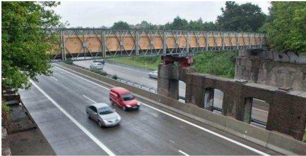
Fertiggestellte Brücke über die BAB A5 bei Eppelheim – Länge 36,60 m
