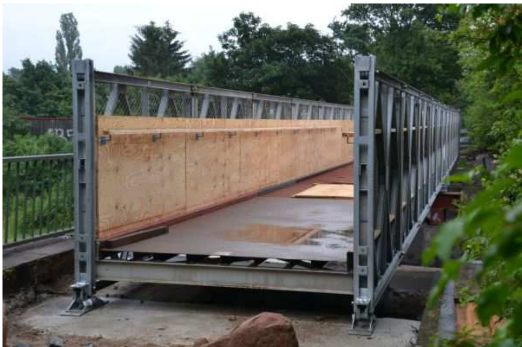
Widerlager Ost – Brücke mit Vertäfelung und Handlauf
