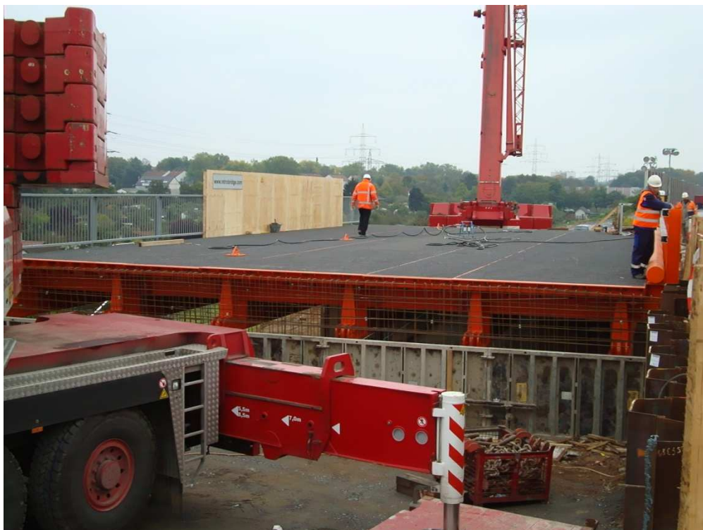
Montage der Brücke DB S-Bahn im Tandemhub aufgrund querender Hochspannungsleitungen über der Behelfsbrücke
