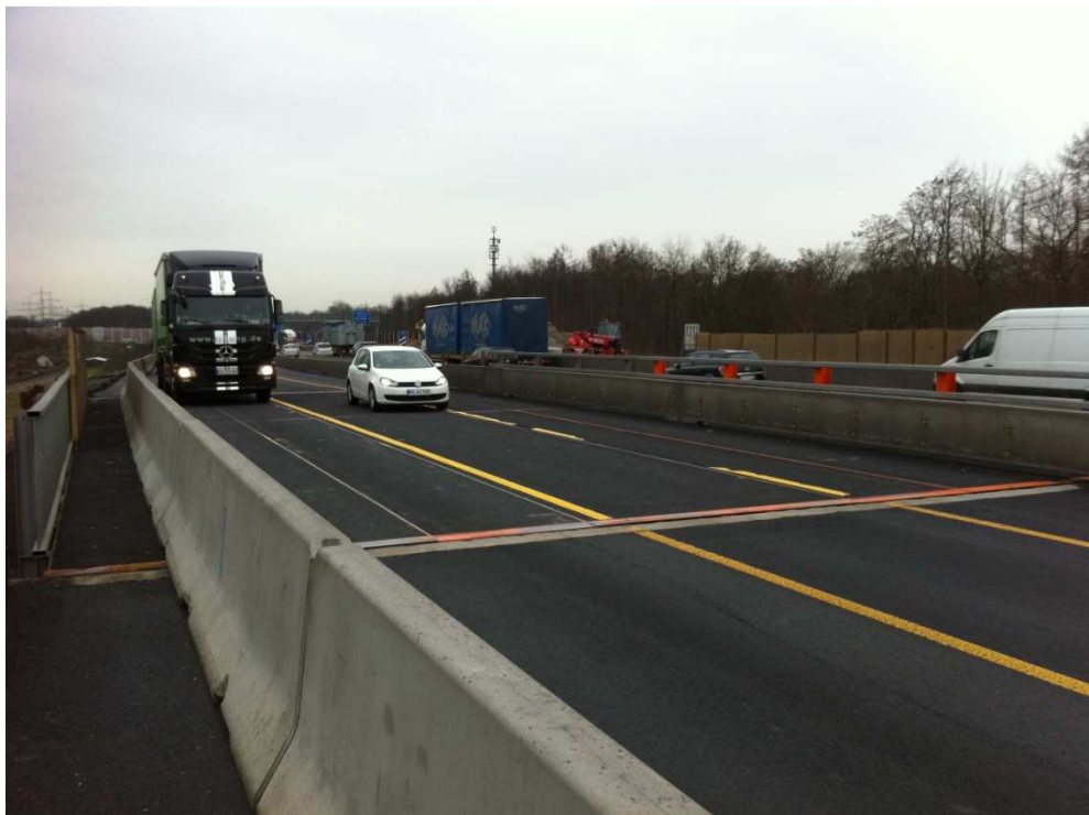
Brücke in der BAB A3 in Köln mit Notgehweg und 3 Fahrspuren
