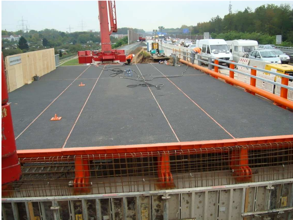
Montierte RLB-Behelfsbrücke, Länge 24,00 m, Breite 12,00 m
