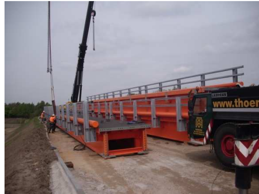
RHB - Behelfsbrücken während der Vormontage mit Fußwegkonsolen
