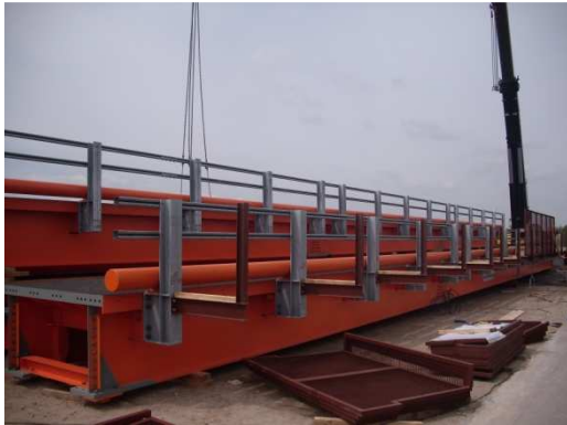
RHB - Behelfsbrücken während der Vormontage mit Fußwegkonsolen
