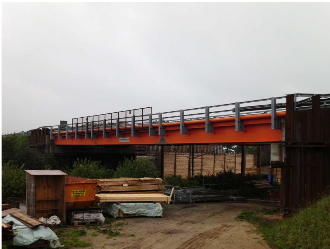
RHB-Brücken über der DB-Strecke mit Berührungsschutz
