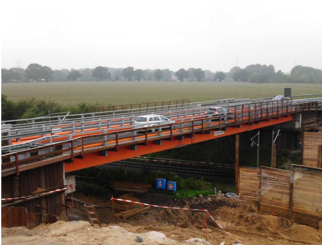
Ansicht der parallel verlaufenden RHB - Verkehrsbrücken in der BAB A23 mit angehängtem Fußgängerweg für Baustellenpersonal
