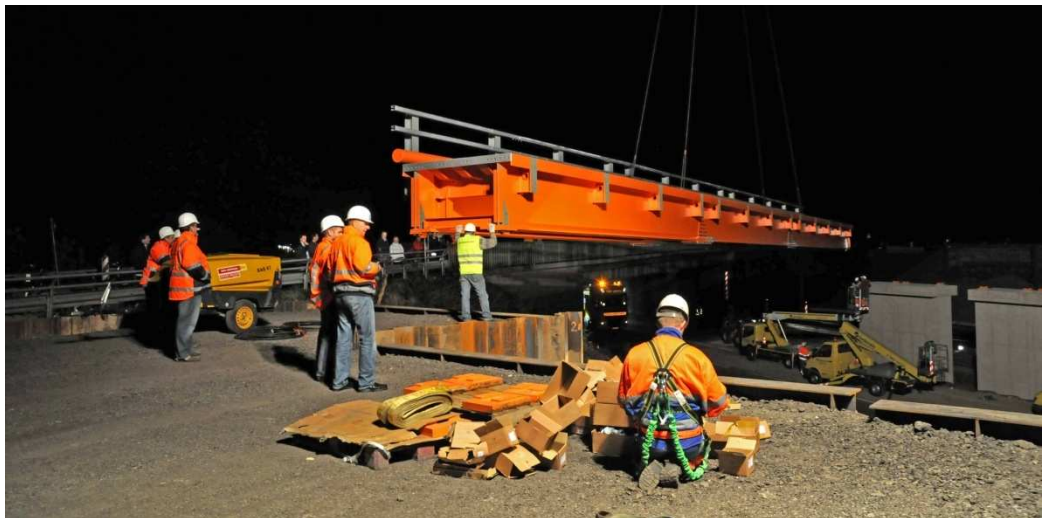
Einheben des ersten RHB-Brückenelementes (1 e Nacht) über der Richtungsfahrbahn Bremen
