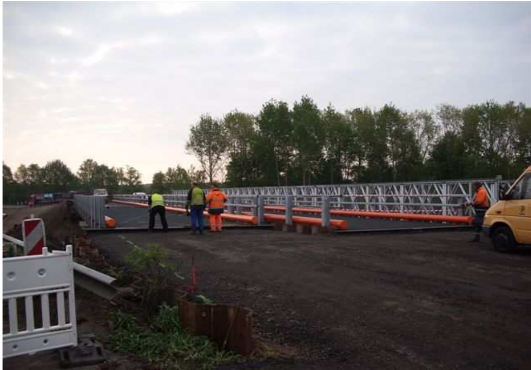
Widerlagerseite mit anschließender Umfahrung
