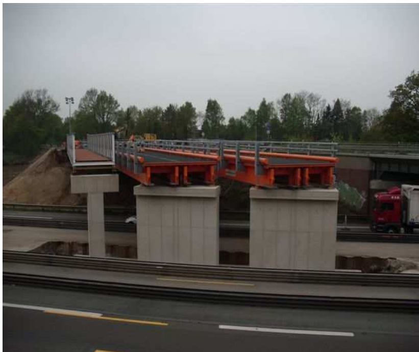
Montierte Behelfsbrücken über RF Bremen nach der 1 e Nacht
