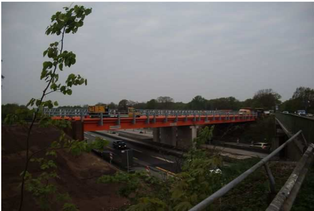
Fertiggestellte Behelfsbrücken nach der 2 e Nacht – direkt im Anschluß wurde mit den Baumaßnahmen im Anschlussbereich durch die ARGE A1 Hamburg-Bremen begonnen
