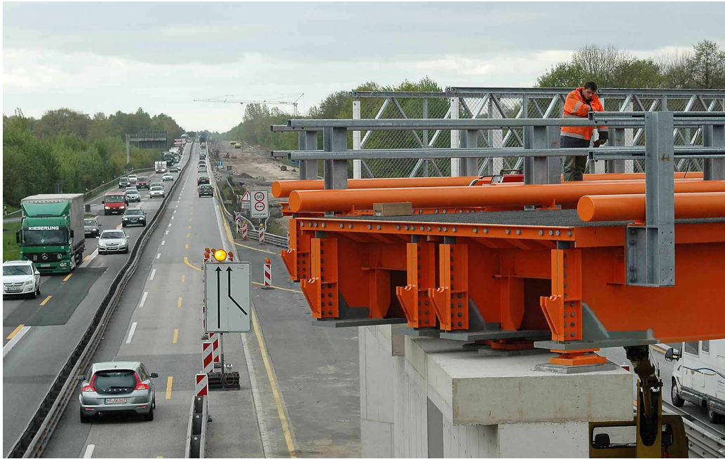
Vorbereitungen für die 2 e Nacht – Auflager- und Koppelstelle der RHB-Brücken auf der Mittelstütze
